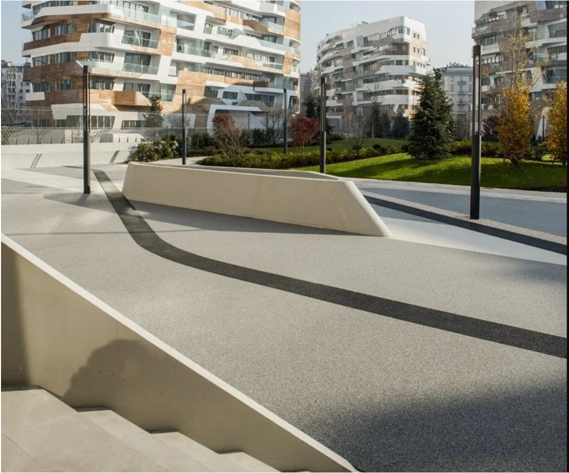
pavimentazione in conglomerati in graniglia (esempio)
